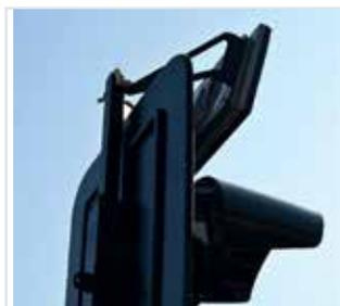
Staffa per dispositivo count-down a LED (vista posteriore)
